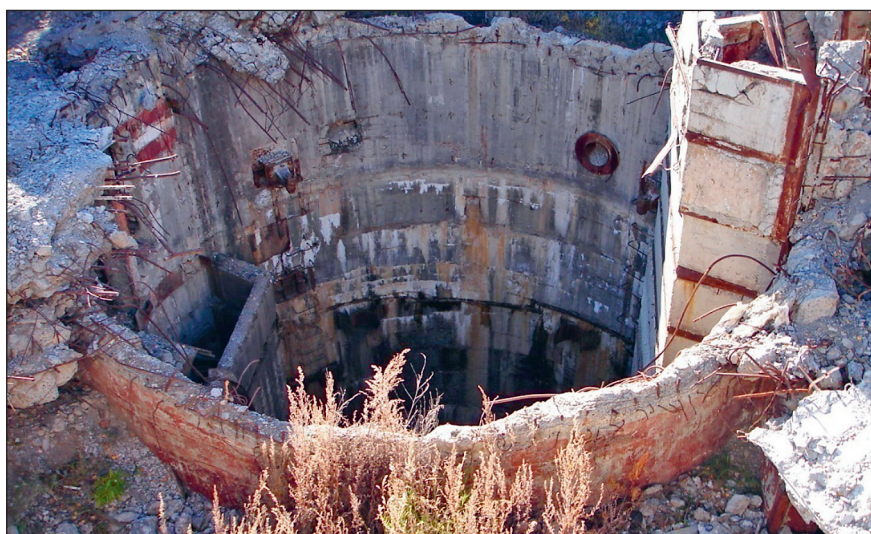
► Рис. 3. ШПУ, частично заполненная водой, после неполной ликвидации в 1977 г.
