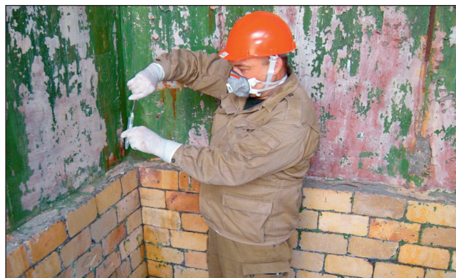
► Рис. 5. Взятие смывов с поверхности стены хранилища НДМГ площадки № 23.
