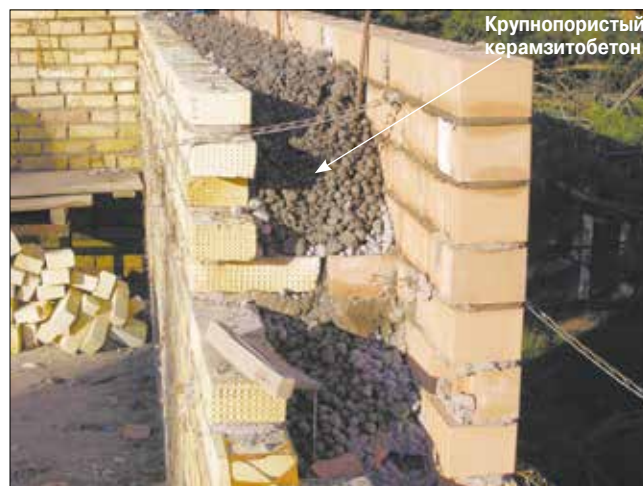
Рис. 2. Колодезная кладка наружных стен с применением крупнопористого керамзитобетона (стадия строительства коттеджа в г. Белебей)
