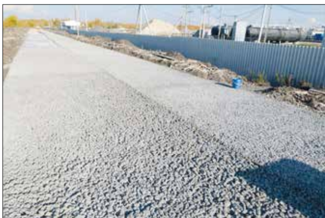
Рис. 5. Слой покрытия автомобильной дороги, выполненный из крупнопористого дренажного бетона КАПСИМЭТ. Пос. Цильна Ульяновской обл., 2014 г.
