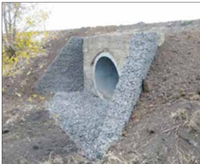
Рис. 7. Обетонирование водопропускной трубы под полотном дороги крупнопористым дренажным бетоном КАПСИМЭТ. Пос. Цильна Ульяновской обл., 2014 г.
