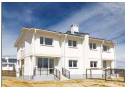
Применение керамзитобетонных блоков «ТермоКомфорт» в строительстве жилья и общественных зданий: а – готовые коттеджи в поселке «Липки» (Смолевичский р-н Минской обл.); б – коттедж на две семьи в жилом микрорайоне «Сокол» (Минск); с – дом паломника при Свято-Елисаветинском женском монастыре (Минск)
