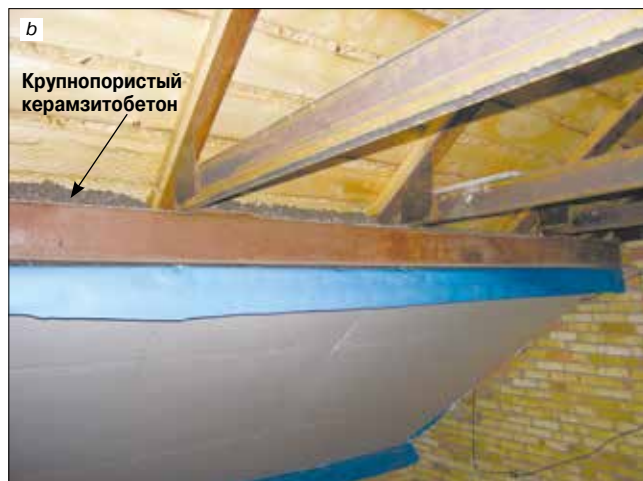
Рис. 3. Возведение мансарды коттеджа с использованием крупнопористого керамзитобетона: а – установка крепежных элементов несъемной опалубки с использованием гипсокартона; б – стадия завершения строительно-монтажных работ
