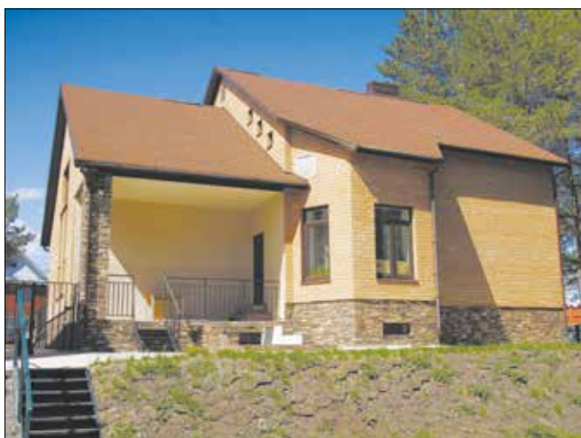
Рис. 1. Коттедж в г. Белебей (крупнопористый керамзитобетон использован в конструкциях наружных стен и мансарды)
